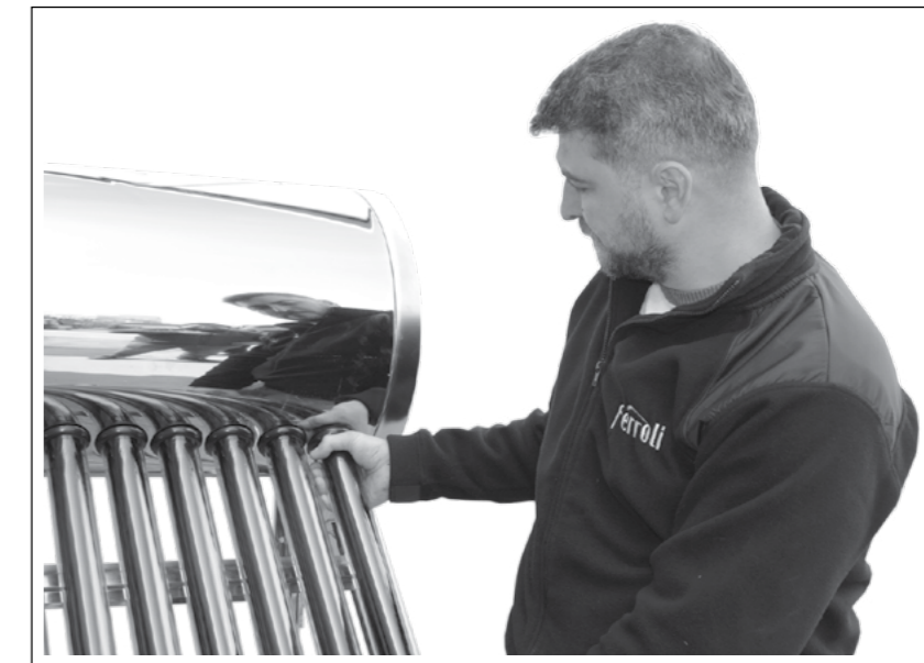
Verificați inelele antipraf pentru a vă asigura că sigilează foarte bine rezervorul
