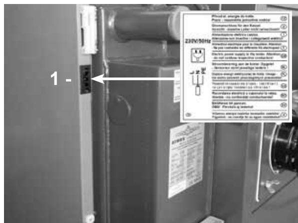
Conectori în partea dreaptă a cazanului
