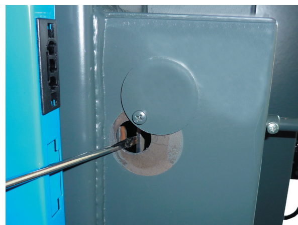
Verificarea și curățarea reglajului raportului de aer primar și secundar, prin orificiul de curățare
