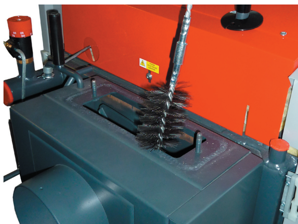
Exemplu de curățare a canalului de fum cu ajutorul unei perii de sârmă – capacul superior
